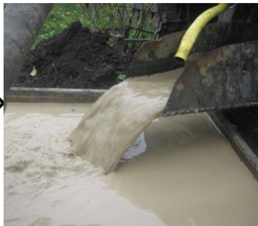
Промывка ствола (буровой раствор)
