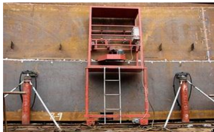
Сварка горизонтального шва стенки резервуара
