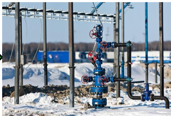
Установка фонтанной арматуры и вскрытие пласта, добыча «флюида»
