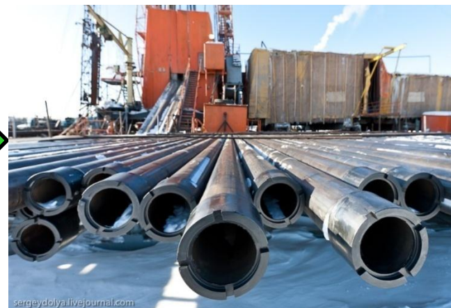
Крепление ствола (обсадные трубы, наращивание труб)
